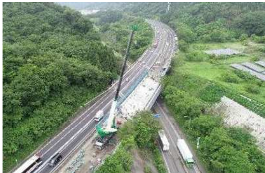
東北自動車道 越河橋の床版取替工事
