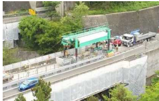
長野自動車道 中曽根川橋の床版取替工事
